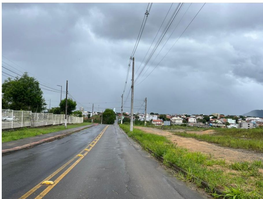
Figura 47 – Ponto 1, vista em direção a Vila Nova. Fonte: Vivacidade, 2024.
